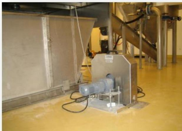
La chaîne est contrôlée par un moteur électrique. De ce fait, le système a une faible consommation d'énergie et un faible coût d'entretien. L'avantage de ce type de racleur est de pouvoir couvrir la cuve ou le bassin avec une bâche afin d'éviter des odeurs gênantes et une chute dans le bassin.
