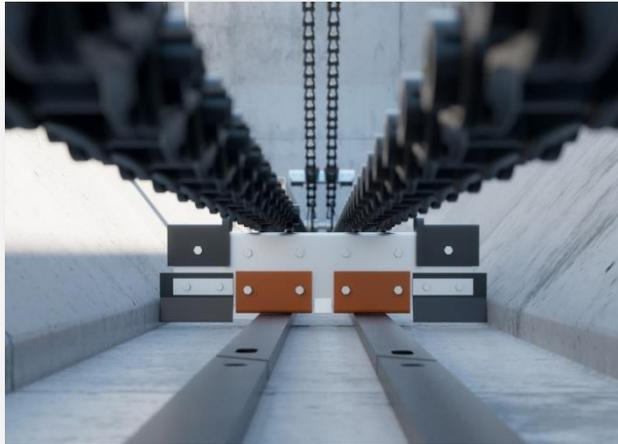
Il est composé de plusieurs racloirs adaptés pour un raclage efficace. Ce type de racleur est souvent utilisé dans des dessableurs longitudinaux. La taille du racloir est modifiable en fonction de la largeur de la cuve ou du bassin.
