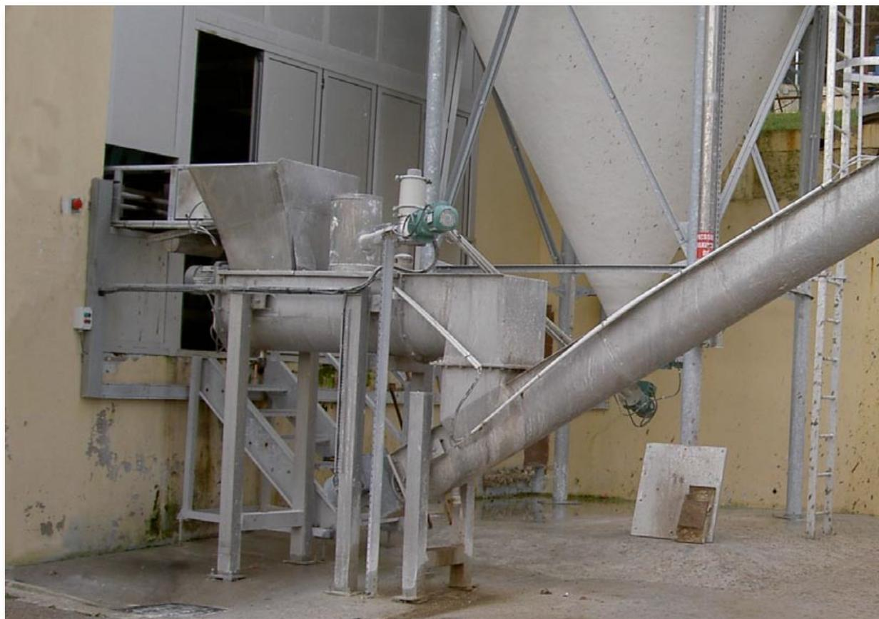
Ce malaxeur assure un mélange homogène entre la boue et la chaux sans dénaturer la structure de la boue.
