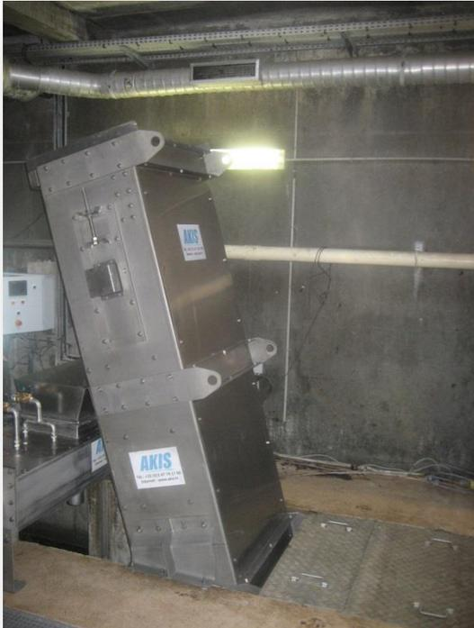
Grâce à son fonctionnement basé sur un système de plusieurs racles et par sa fonction autonettoyante, le dégrilleur multi-racles AKIS offre une efficacité considérable pour le traitement des eaux et des déchets. Plusieurs racles sont en contact avec la grille, ce qui permet d'amener plus rapidement les déchets vers la sortie de la machine. Ceci permet également le traitement de forts débits d'eau contenant beaucoup de déchets.
